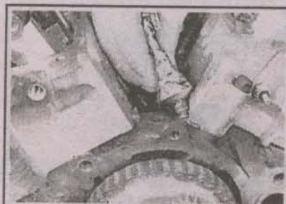
7.8 Нанесение герметика перед установкой коллектора
